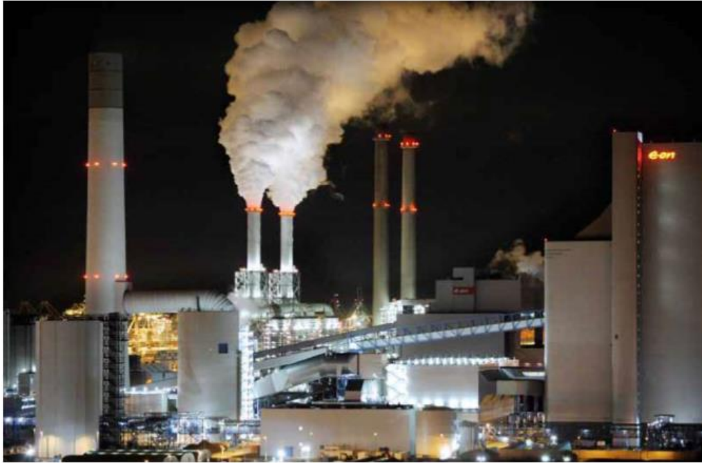
De nieuwe op kolen gestookte energiecentrale van E.ON op de Maasvlakte
